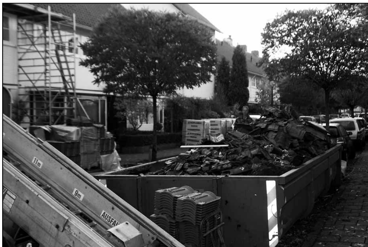
• De dakpannen uit de Sint-Odulphusstraat verdwenen in de container.
