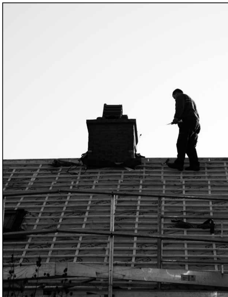
• Werk aan de daken in de Sint-Odulphusstraat.
