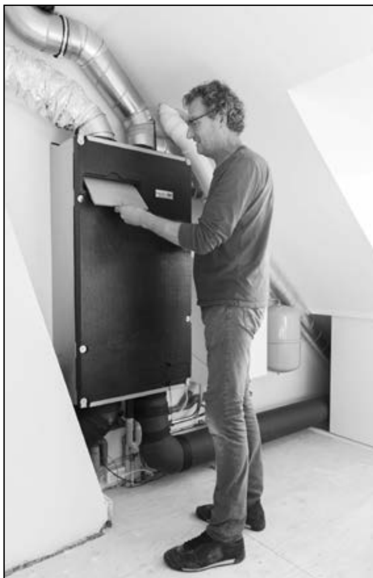
• Ton van der Pluijm met een filter van de warmteterugwin-installatie van zijn mechanische ventilatiesysteem.
